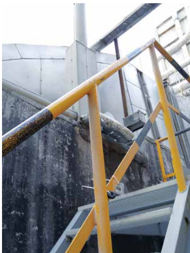
Fot. 7. Widoczne Tagi RFID w wykonaniu pastylkowym przy- mocowane do elementów konstrukcyjnych, stanowiące punk- ty logowania pracowników technicznych
