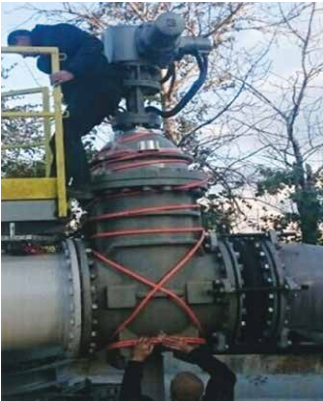
Fot. 7. Element grzewczy zamocowany na powierzchni korpusu zaworu
