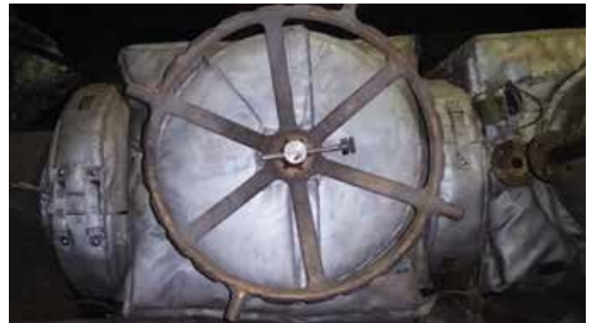
Fot. 5. Zainstalowany na zaworze DN 400 kompletny pokrowiec grzewczo-termoizolacyjny
