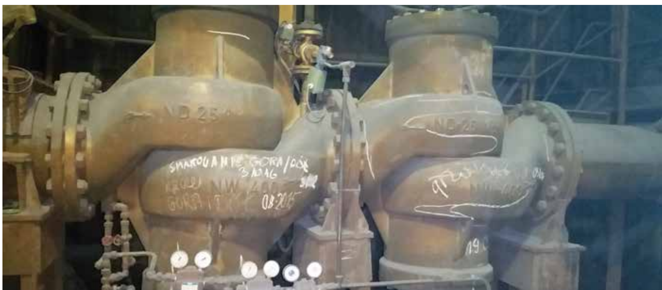
Fot. 1. Zawory DN 400 przeznaczone do powierzchniowego ogrzania przed powstawaniem kondensatu wodnego
