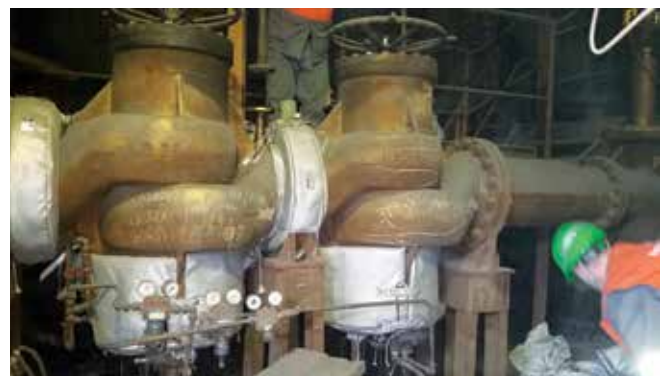
Fot. 4. Montaż poszczególnych elementów pokrowca na osprzęcie instalacyjnym stanowiącym wyposażenie zaworów
