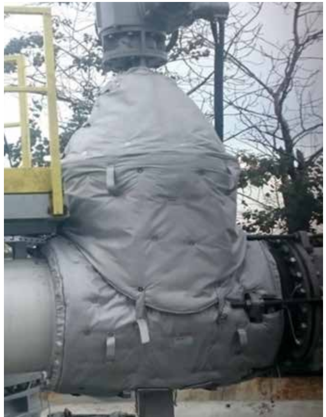
Fot. 8. Osłonięty element grzewczy osłonięty specjalnym elastycznym pokrowcem termoizolacyjnym
