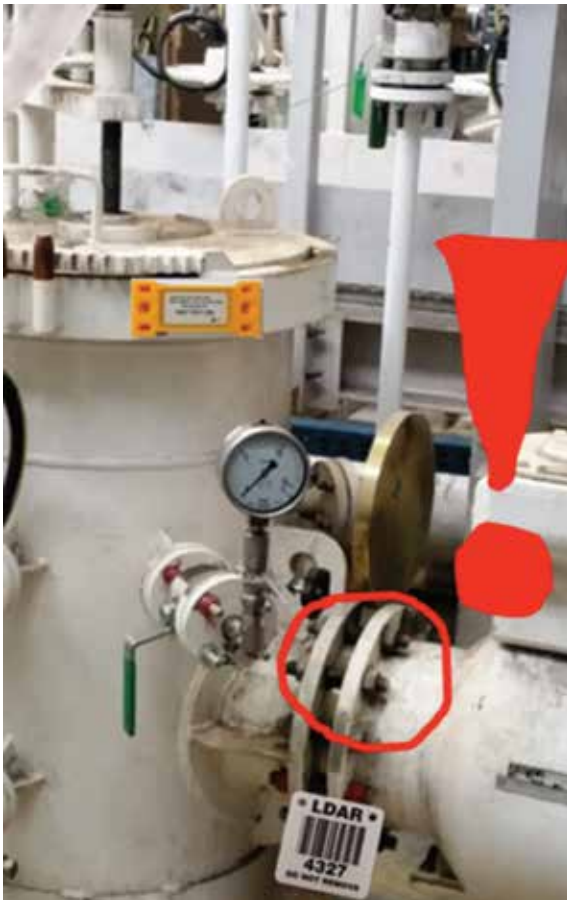
Rys. 8. Zdjęcie stanowiące załącznik do raportu z programu Inspector-LDAR. Identyfikacja i oznaczenie miejsca emisji.
