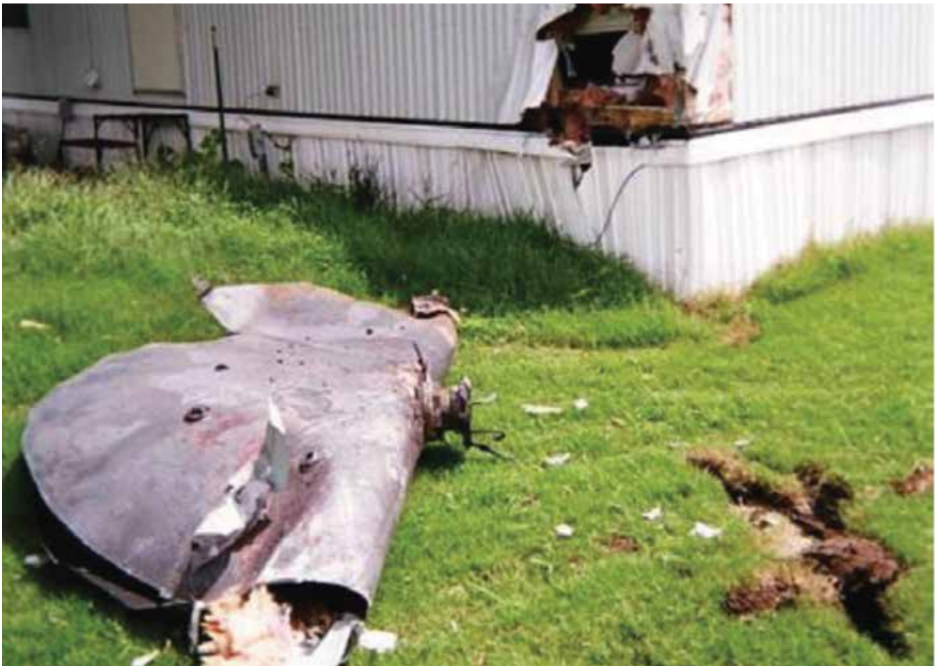
Zdj. 1. Stalowa konstrukcja dachu zbiornika po uderzeniu w dom
